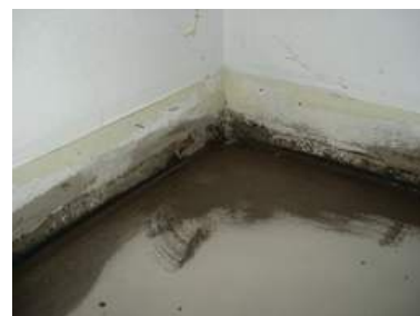
Kanten und Boden sind versiegelt
