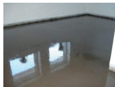
Der fertige Radonschutz nach nur 24 Stunden
