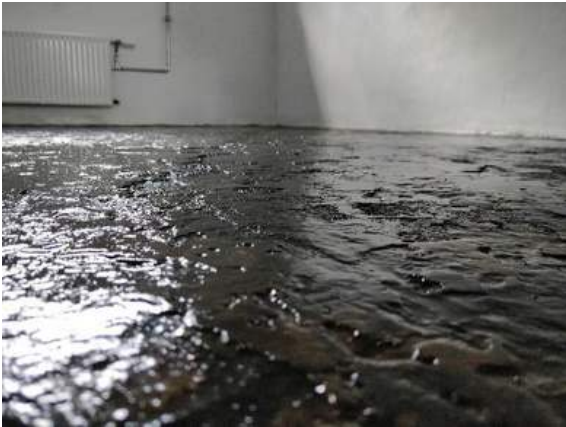
#3 Nach ca. 24 Stunden ist die Membran ausgehärtet und der Boden kann weiter behandelt werden.
