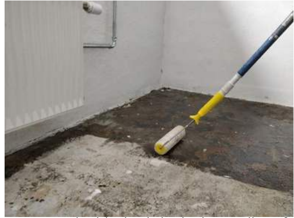
#2 SPS Radonblock wird mit einer Rolle auf die Bodenflächen aufgetragen.
