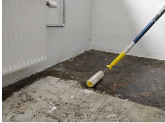
#2 Gulvfladerne påføres SPS Radon block med rulle.
