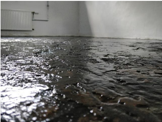
#3 Efter ca. 24 timer er membranen afhærdet og gulvet kan viderebehandles.
